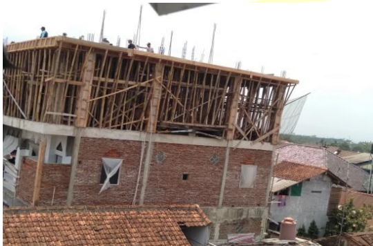
Roan santri saat pengecoran masjid lantai 4
