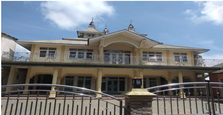
Masjid Jam'i, Masjid Baitul Wustho dusun Majatengah
