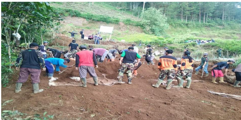
Pembangunan Gedung MWC di dusun Majatengah
