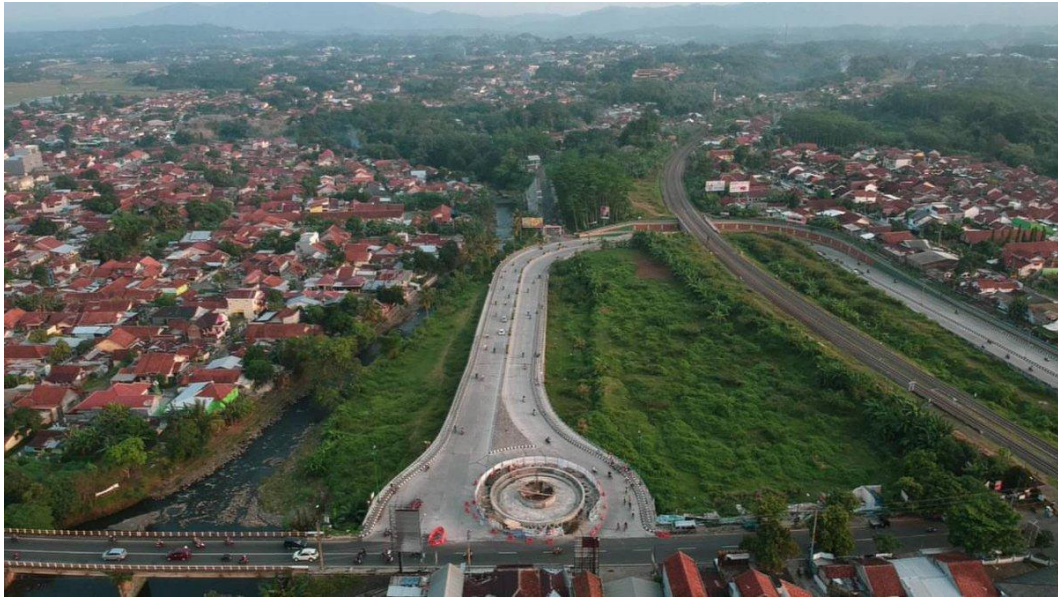
Tampak underpass dari atas, sumber: google
