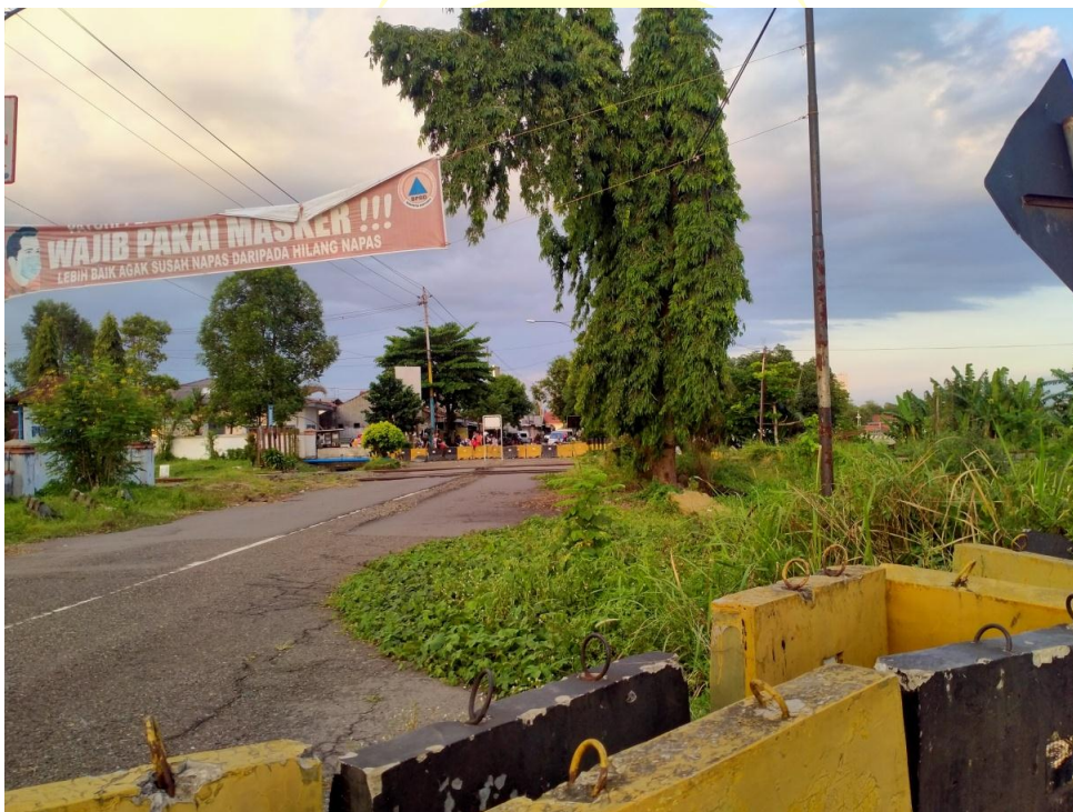
Rel kereta yang dulu dilewati pengendara sebelum adanya underpass
