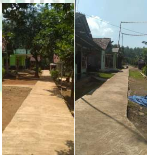
Gambar 1.2 Pembangunan Jalan Rabat Beton
