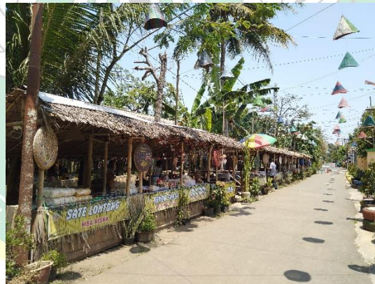
Gambar 1. 2 Kondisi pasar Panggok sebelum renovasi
