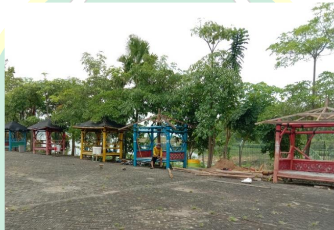
Gambar 3 Perbaikan fasilitas tempat wisata
