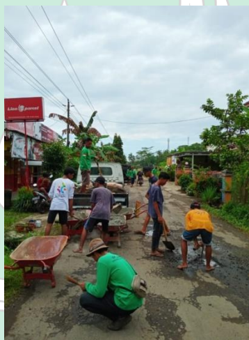
Gambar 18.B : Proses Penambalan Jalan Berlubang
