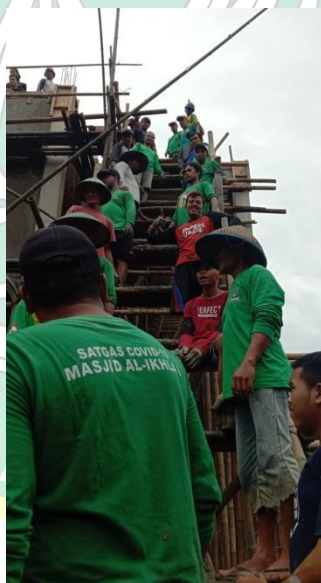
Gambar 7.A : Kerja Bakti Pembangunan Gedung MWCNU Binangun
