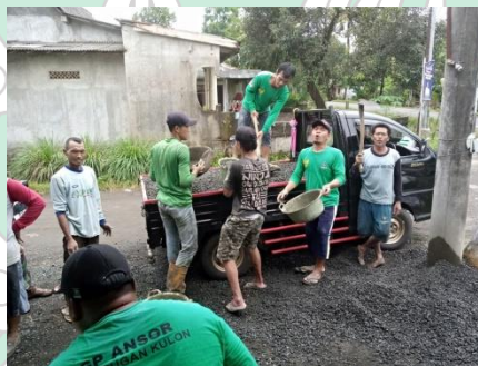
Gambar 17.B : Donasi Bahan Material untuk Pembangunan gedung MWCNU Binangun
