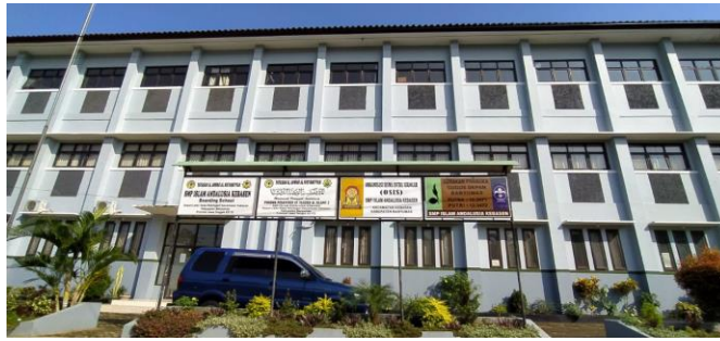
Gedung SMP Islam Andalusia Kebasen Banyumas.
