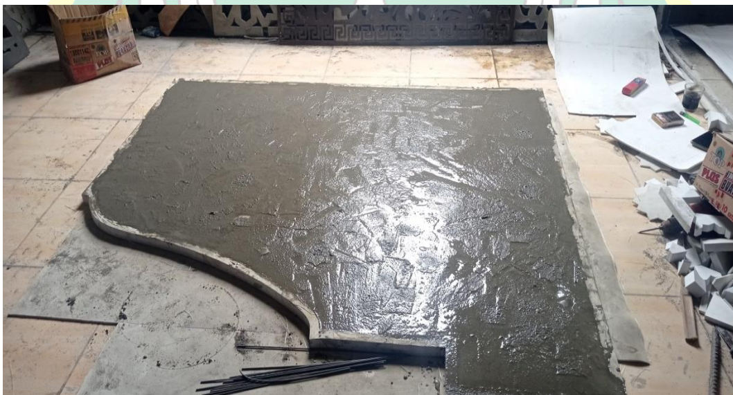
Gambar 4.12 Cetakan Setelah di Isi Adonan
