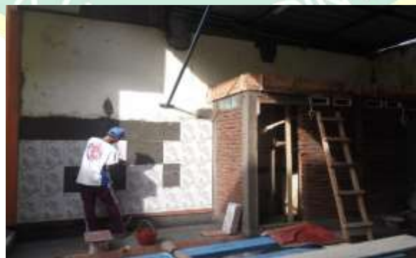
Gambar 3 Bantuan Pembangunan Tempat Wudhu dan Kamar Mandi
