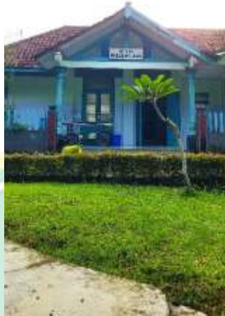
Gambar 1.12 Ruang Instalasi Pemulasaran Jenazah, Forensik, dan Kerohanian
