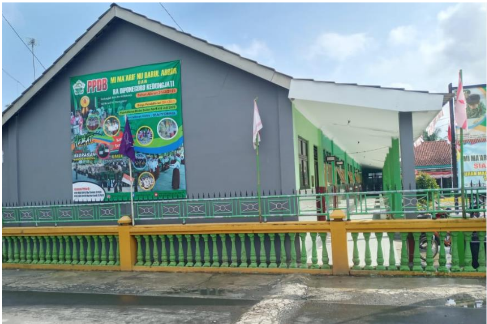
Gambar 2 Foto bangunan tampak samping MI Ma'arif NU Darul Abror, Kedungjati, Bukateja, Purbalingga.
