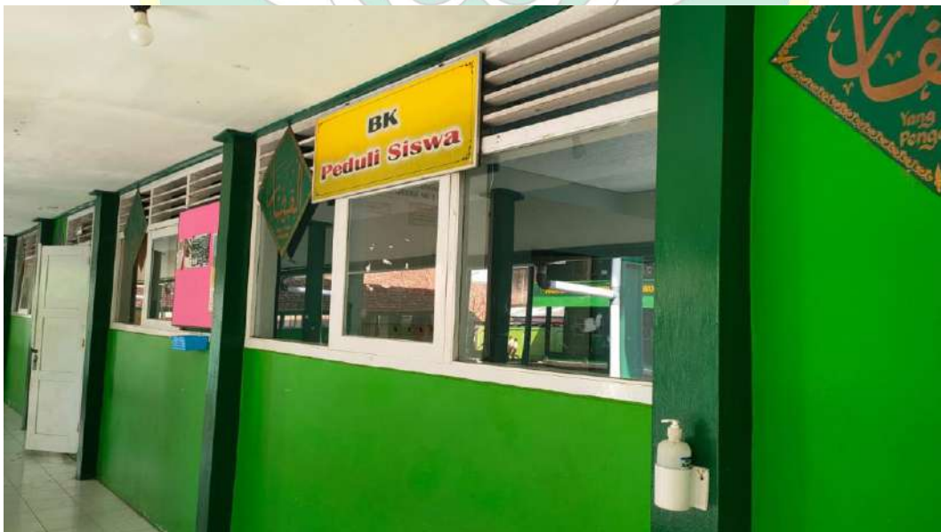
Tampak Luar ruang Bimbingan Konseling Dokumen: Pribadi
