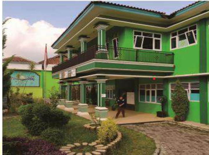
Gedung SMP Ma'arif NU 1 Ajibarang Dokumen: Sekolah
