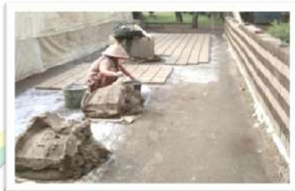
Gambar 4.4 Proses Pencetakan Batu Bata
