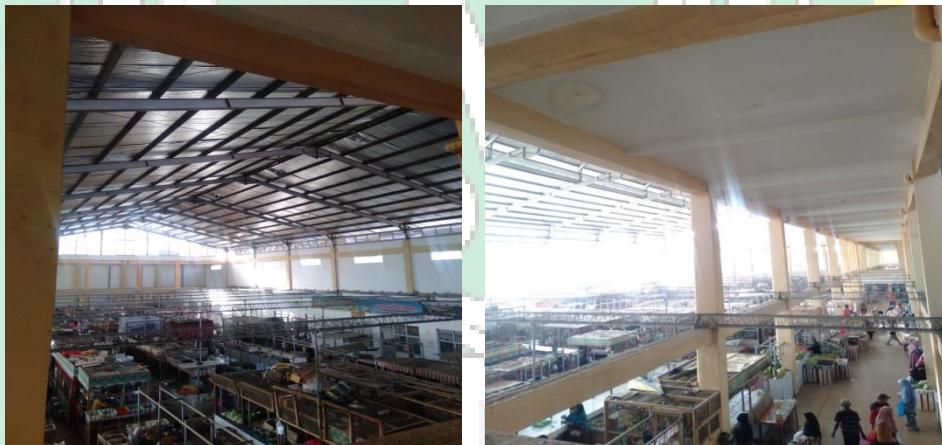
Kondisi Pasar Sumpiuh
