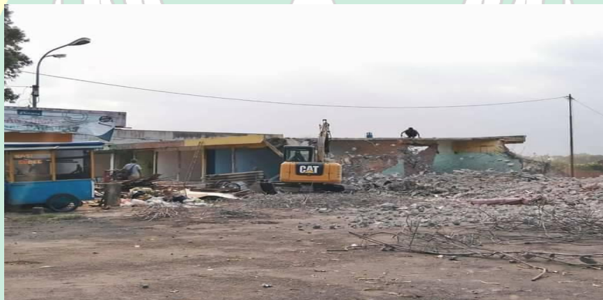
Dokumentasi Pembongkaran Bangunan Lama Pasar Rakyat Pon Purwokerto
