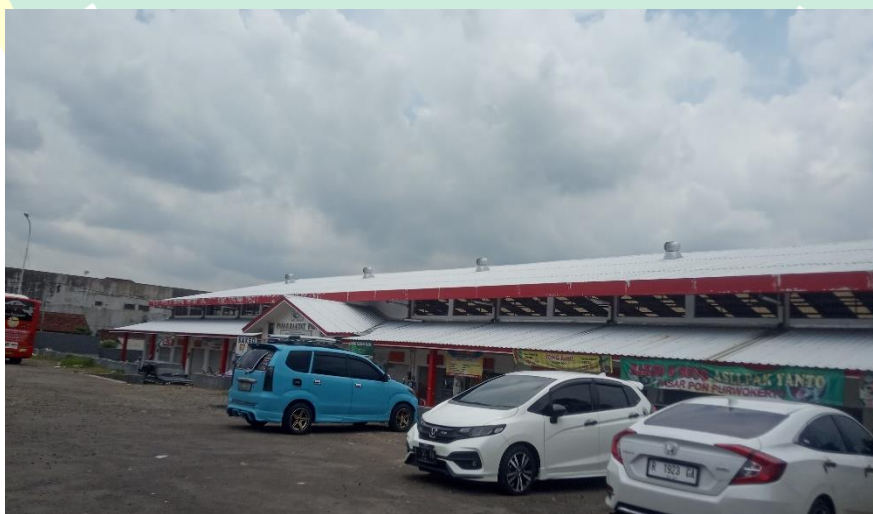
Dokumentasi lahan parkir Pasar Rakyat Pon yang luas setelah revitalisasi
