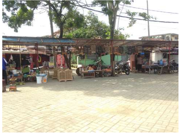
Kondisi Pasar Peksi Bacingah
