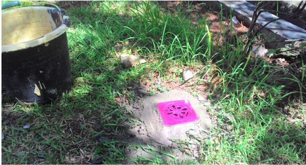
Hasil pembuatan lubang resapan biopori
