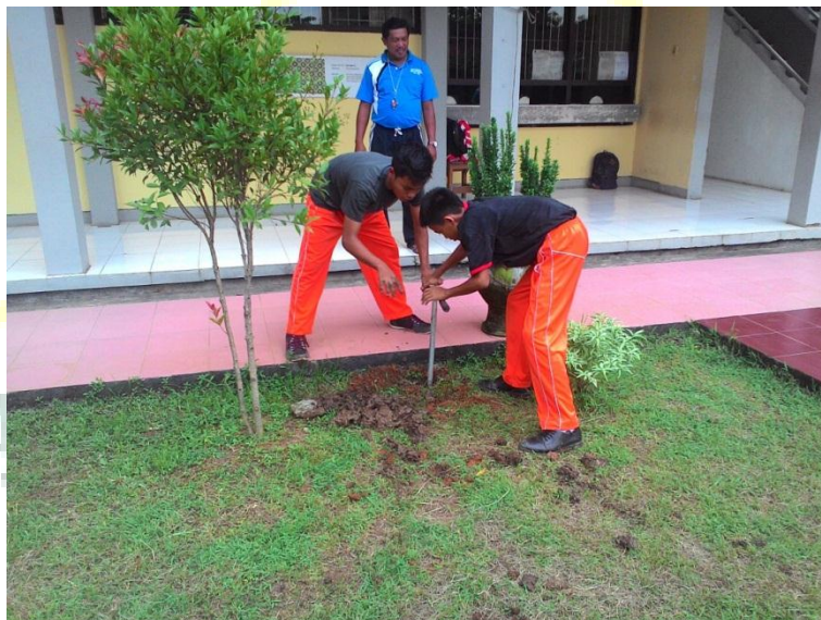
Proses pembuatan lubang resapan biopori
