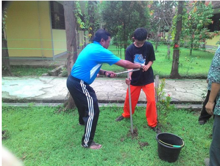
Proses penggalian tanah untuk lubang resapan biopori oleh siswa dibantu pembimbing
