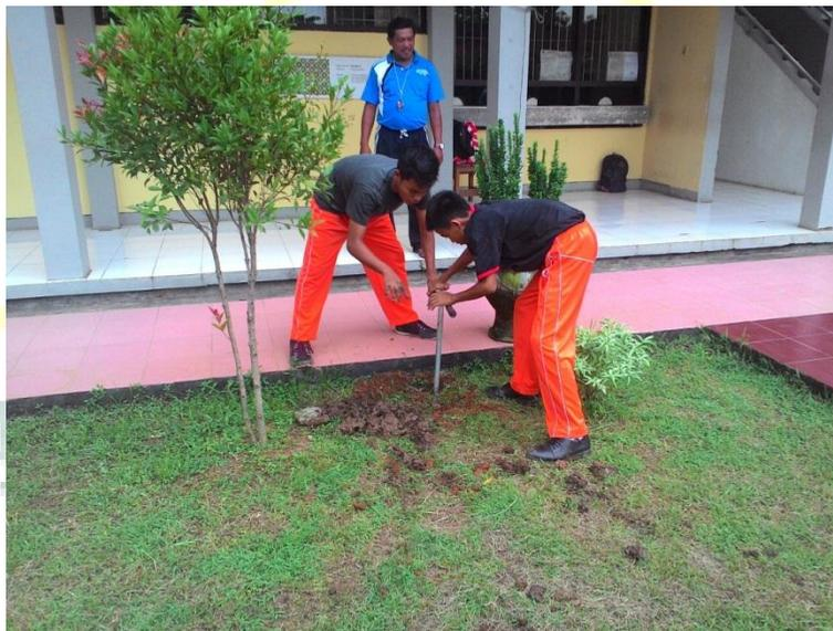
**Proses pembuatan lubang resapan biopori**
