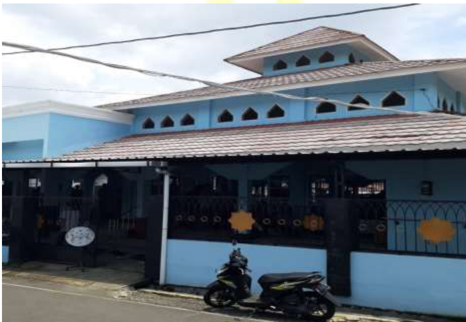
Bangunan utama Masjid Baitul Arqam dilihat dari dekat (Sebelah Utara)
